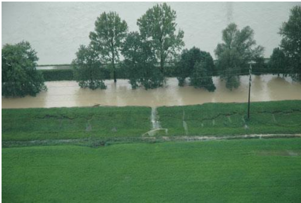
Hochwasser 2005 – gefährdete Dämme
