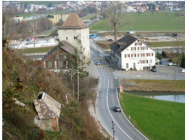
Links einer der Bunker der Infanteriefestung Grynau – Aufnahme von 2011
